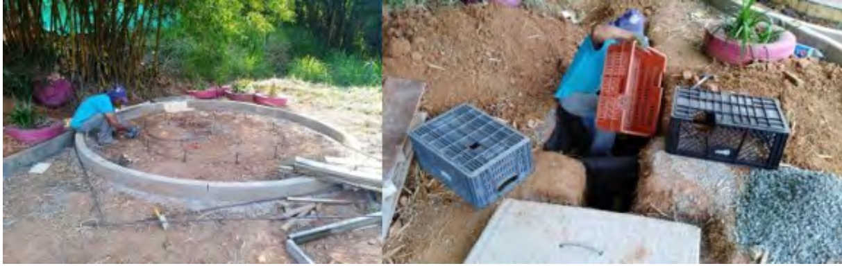
Figura 13. Construcción de las bases y tanques de tormenta
